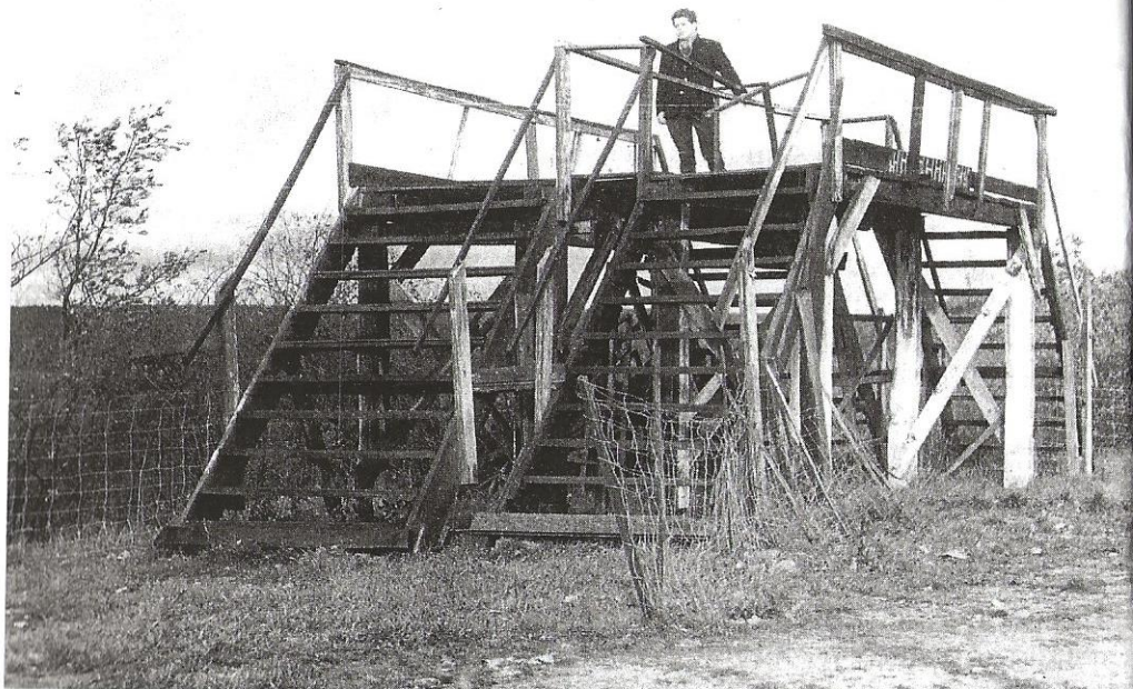
Poulangy : démolition de la passerelle. Le 16 novembre 1964
